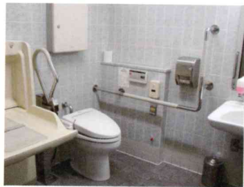
▲ Multi-purpose Toilet 多目的洗手间 다목적 화장실
